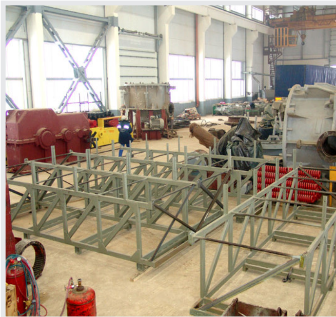
Металлоконструкции зоны Б
