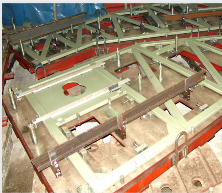
Секции металлоконструкции зоны А на стапеле
